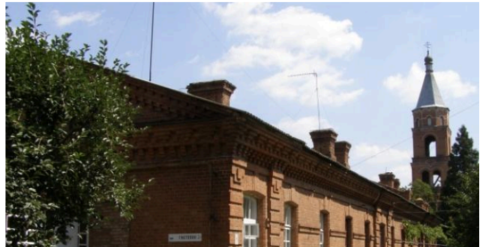
Іл.41. Житлові будівлі для 12-ї артилерійської бригади
